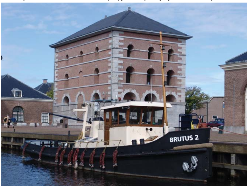
Motorsleper Brutus 2 voor het monumentale pompgebouw bij de ingang van het werfcomplex
