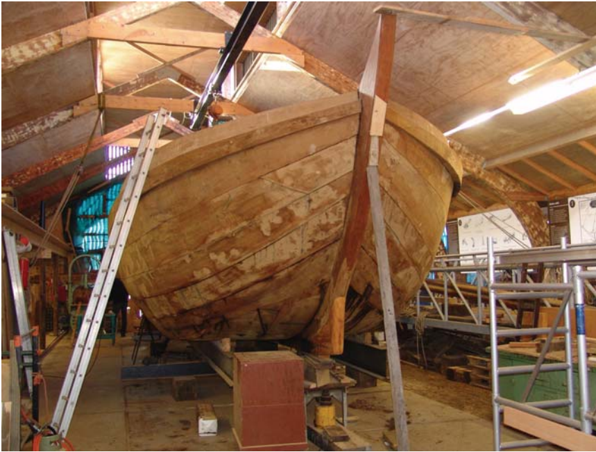
Restauratie van de botter HD 2 in de Medemblickerloods
